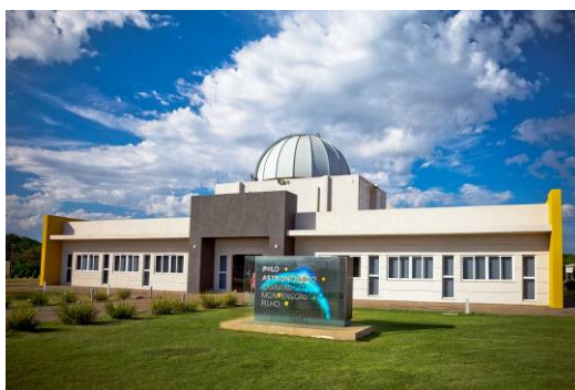
Figura 1: Fachada do prédio do Polo Astronômico. Fonte: Os autores (2017)
